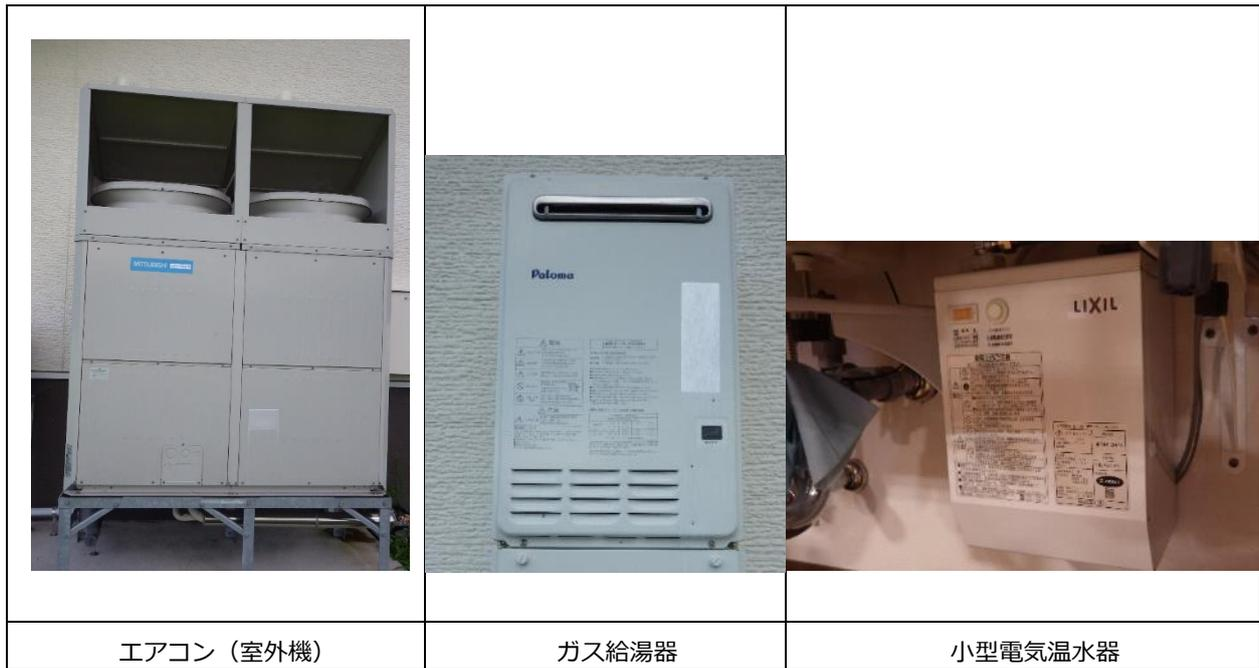
図 5-17 すわの郷に設置されている暖房・給湯設備
