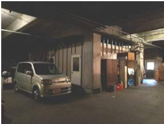
図 4-30 ボイラー設置候補場所の様子
