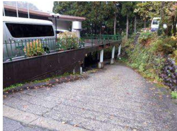
図 4-31 ボイラー設置候補場所へのアクセス 通路
