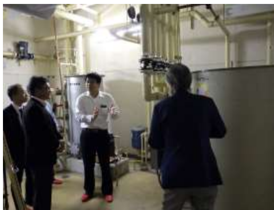
図 4-3 ボイラー室の視察
