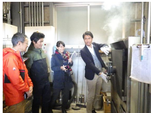
写真 11 西目屋村視察（薪ボイラー）
