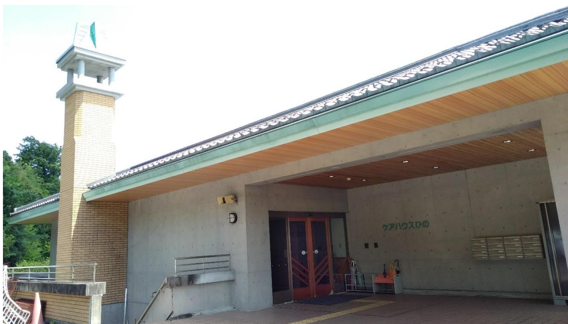
写真 3-16 誉の松 外観（ケアハウス）
