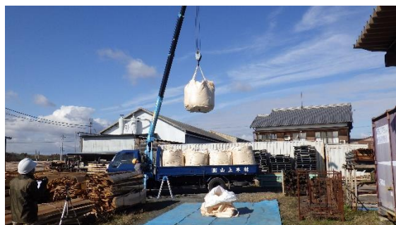
写真 3-13 フレコンバック積み下ろし
