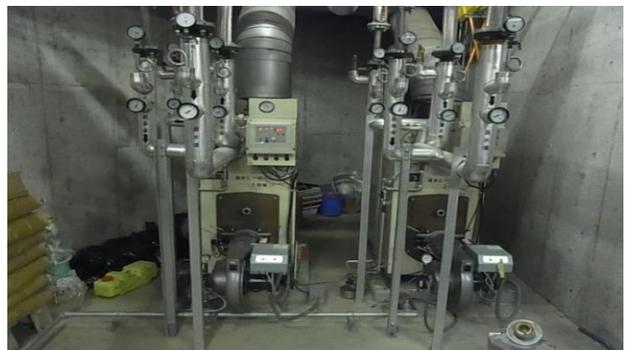
写真 2-5 給湯用ボイラー (2 基)
