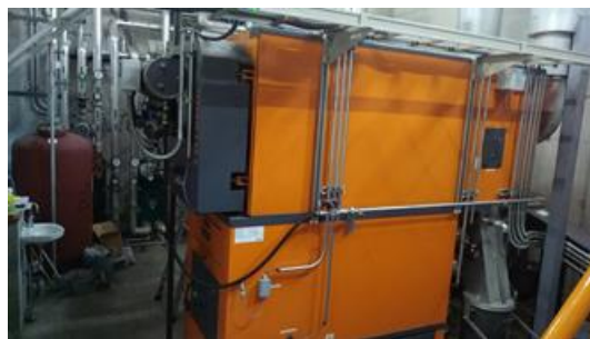
写真 2-9 左：氷太くんチップボイラー建屋 右：チップボイラー本体
