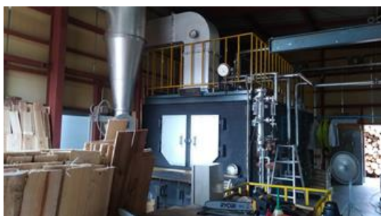
写真 2-4 左：木屑焚きボイラー 右：木材乾燥機（高温乾燥機）
