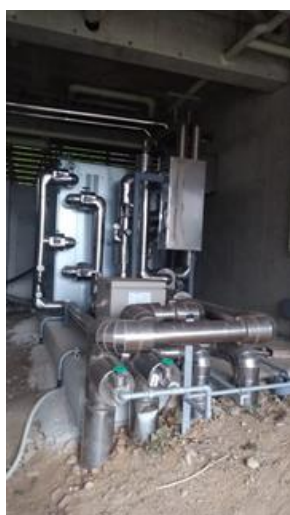
写真 2-10 左：温水焚き冷温水機 真ん中：灯油焚き冷温水機 右：灯油ボイラー
