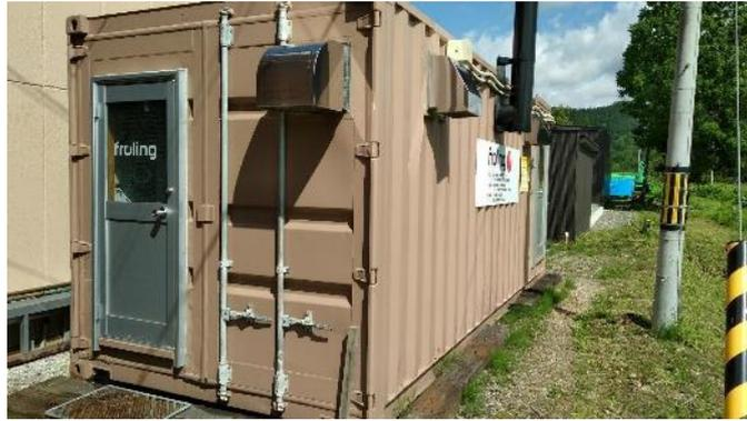
写真 21 チップボイラーのコンテナ格納例
