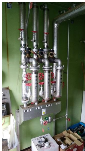
写真 3-7 重油ボイラー（左：本体、中央：蒸気ヘッダー、右：今回確認した蒸気圧力計）
