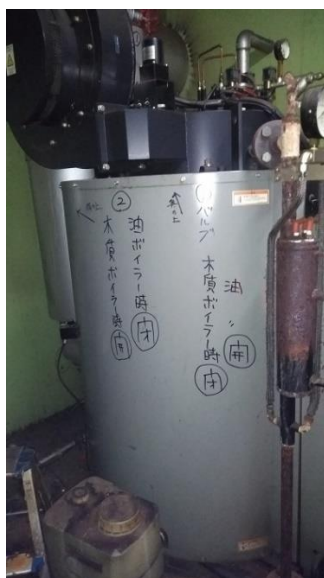
写真 3-7 重油ボイラー（左：本体、中央：蒸気ヘッダー、右：今回確認した蒸気圧力計）
