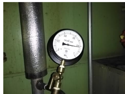
写真 3-7 重油ボイラー（左：本体、中央：蒸気ヘッダー、右：今回確認した蒸気圧力計）
