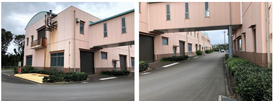
写真 6-10 チップボイラー導入候補先（施設外観）
