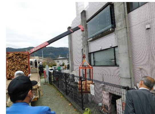
薪ラックの搬入試験
