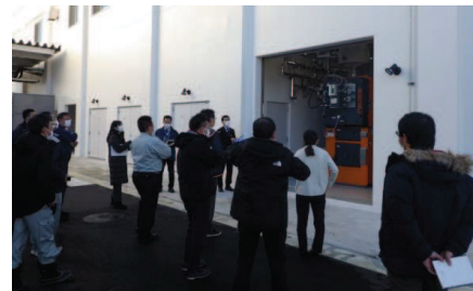
▼新庄警察署のチップボイラー
