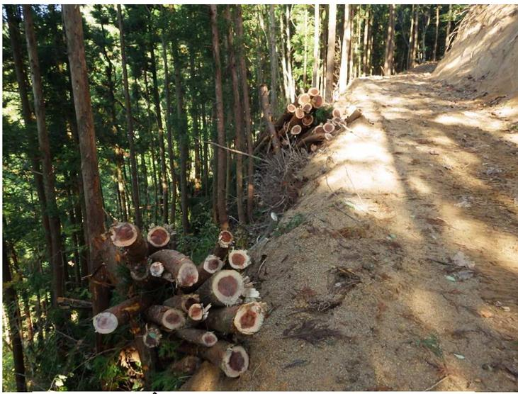
バックホウでの作設では、支障木伐倒はチェーンソーで行うが、伐倒木が不揃いに重なり合い、プロセッサの造材や集材においても危険で時間を要する。
