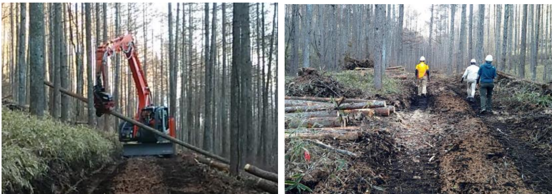
左：ハーベスタによる間伐施業 右：森林作業道
