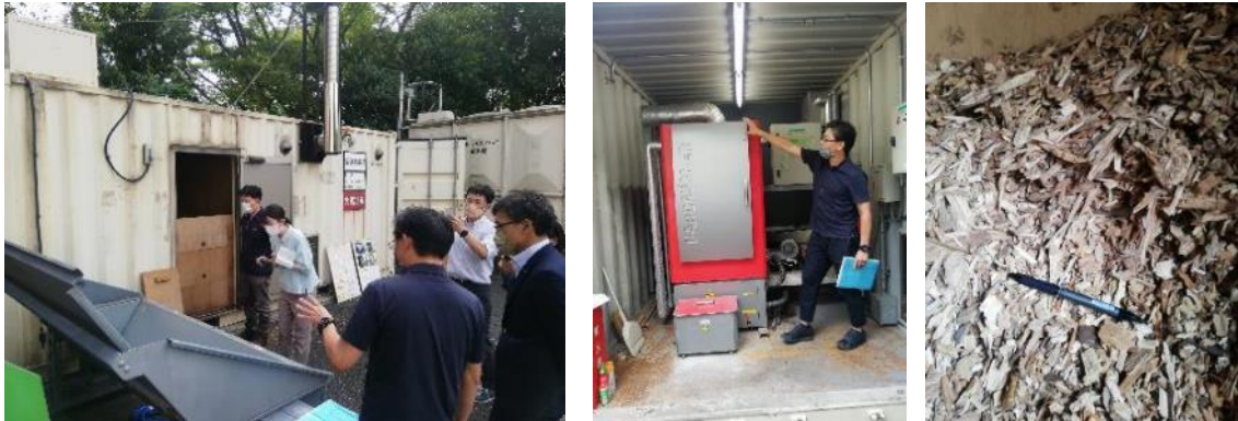
左：コンテナ型チップボイラ設備外観 中：ボイラ室内 右：サイロ内チップ
