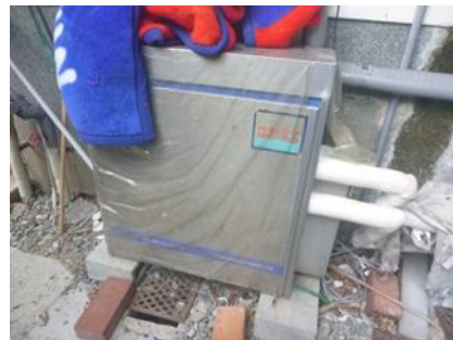
図 3-23 灯油焚きボイラー 電気式ろ過器
