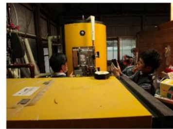
↑チップボイラー メーカー：ETA（オーストリア） 熱出力：19.9kW 燃料：チップ（水分35%W.B以下） ボイラー効率：91～94%
