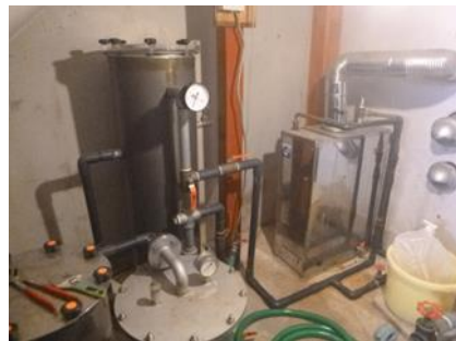
図 3-23 灯油焚きボイラー 電気式ろ過器
