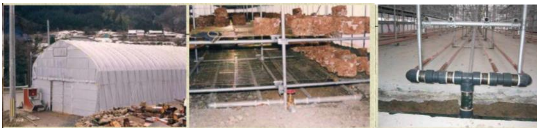
図 3-27 木質バイオマスボイラーによるハウス暖房例
