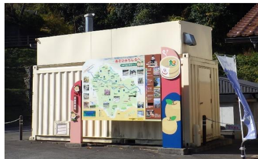
写真 3-2 チップボイラーの建屋
