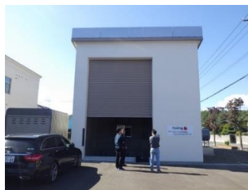
2) 地下式サイロ(後方にボイラー室)
