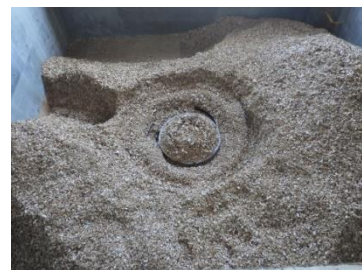
3) サイロ内トップ (左くぼみが燃料供給装置)
