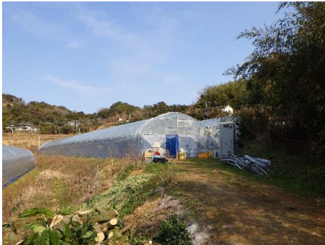
写真 3-41 ハウス（上）の外観
