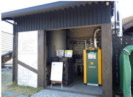
写真 3-7 ボイラー建屋
