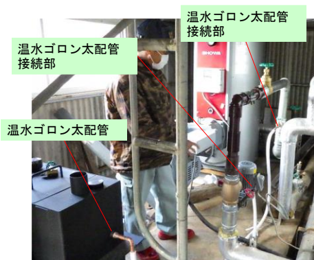
写真 3-26 既存ボイラーとの接続
