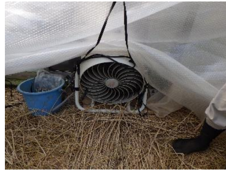
写真 3-31 排熱ダクト（ハウス側）
