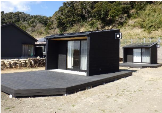
※屋根にソーラーパネルが設置されている 写真 3-20 タイニーハウス外観（宿泊用）
