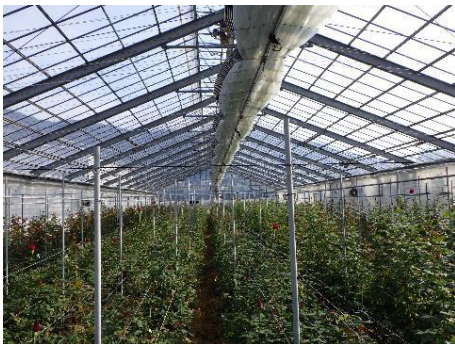
写真 3-32 ハウス 1 の様子
