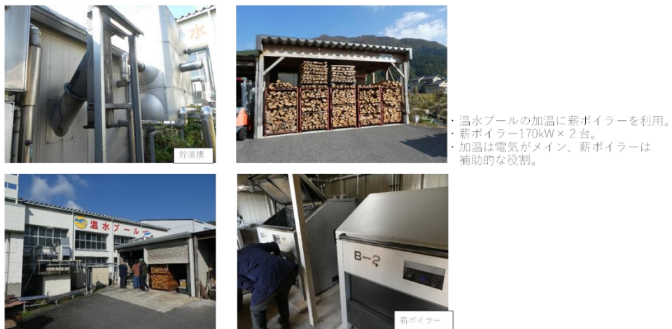
図 3-40 先進地への視察 智頭町（薪ボイラー）
