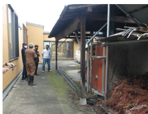
ボイラー設置前
