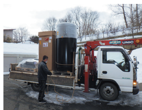
ボイラー到着時
