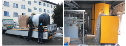
蓄熱タンク到着 / ボイラー搬入・設置 (R5.2/23)
