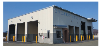
つべつ木質バイオマスセンター
