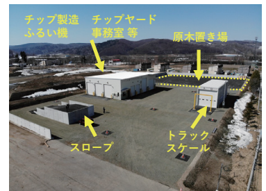
敷地面積：約6,800m 2 設備機能：貯蔵棟(チップ製造、ふるい機、チップヤード、事務室等) トラックスケール・原木置き場 積み込みスロープ
