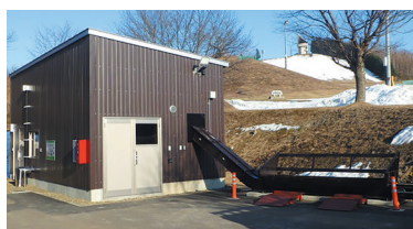
キノス：木質バイオマスボイラー棟
