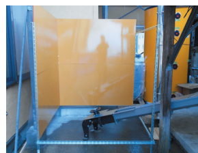
施工中のサイロ
