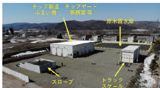
▲写真① 木質バイオマスセンター構内
