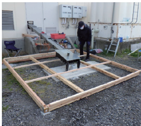
▲写真② DIYによるサイロ設置
