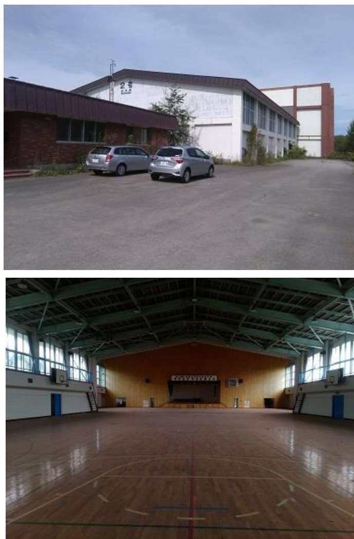
図 3-15 旧道都大学体育館の外観と内部
