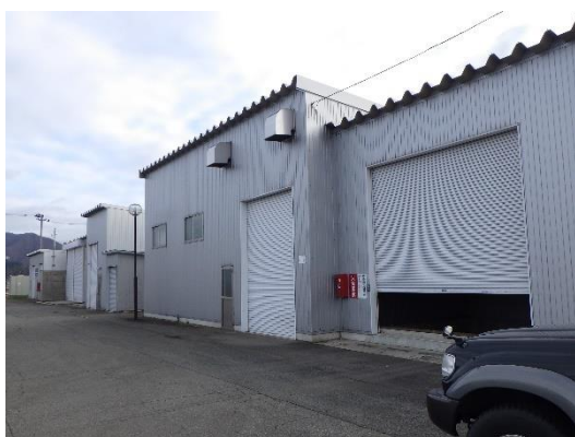
写真 3-3 チップボイラー建屋
