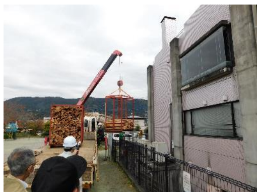
4t クレーン付トラックにて搬入
