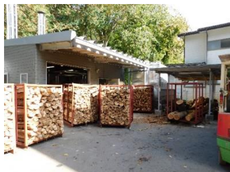
薪ボイラー周辺、フォークリフトを使用
