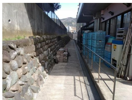
薪ボイラーへの通路
