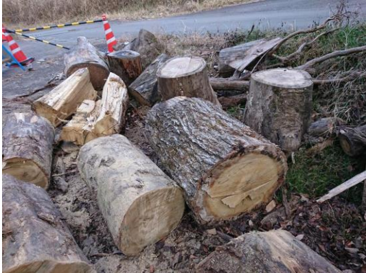
写真 3-3 工事の支障木（径 80cm 以上）
