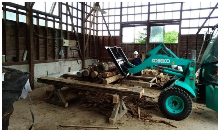
写真 3-5 薪製造ライン
