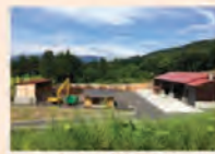
製材施設 H28. 4月稼働開始
