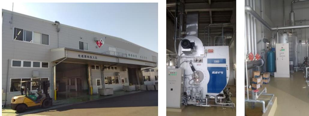
図 3-2 B 施設正面、重油焼き蒸気ボイラー、貯湯タンク
