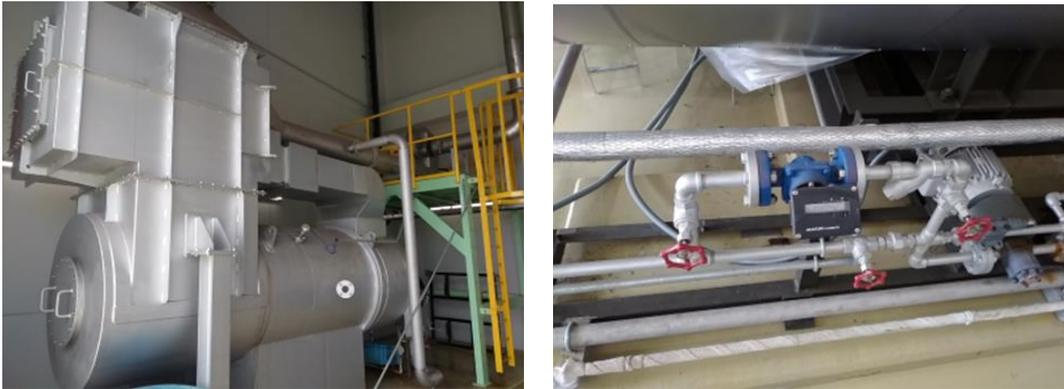
図 3-3 脱臭炉、重油流量計
