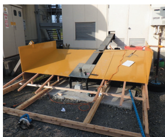
建設中のサイロ
