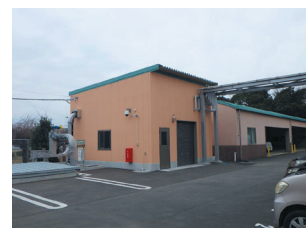
バイオマスボイラー棟
